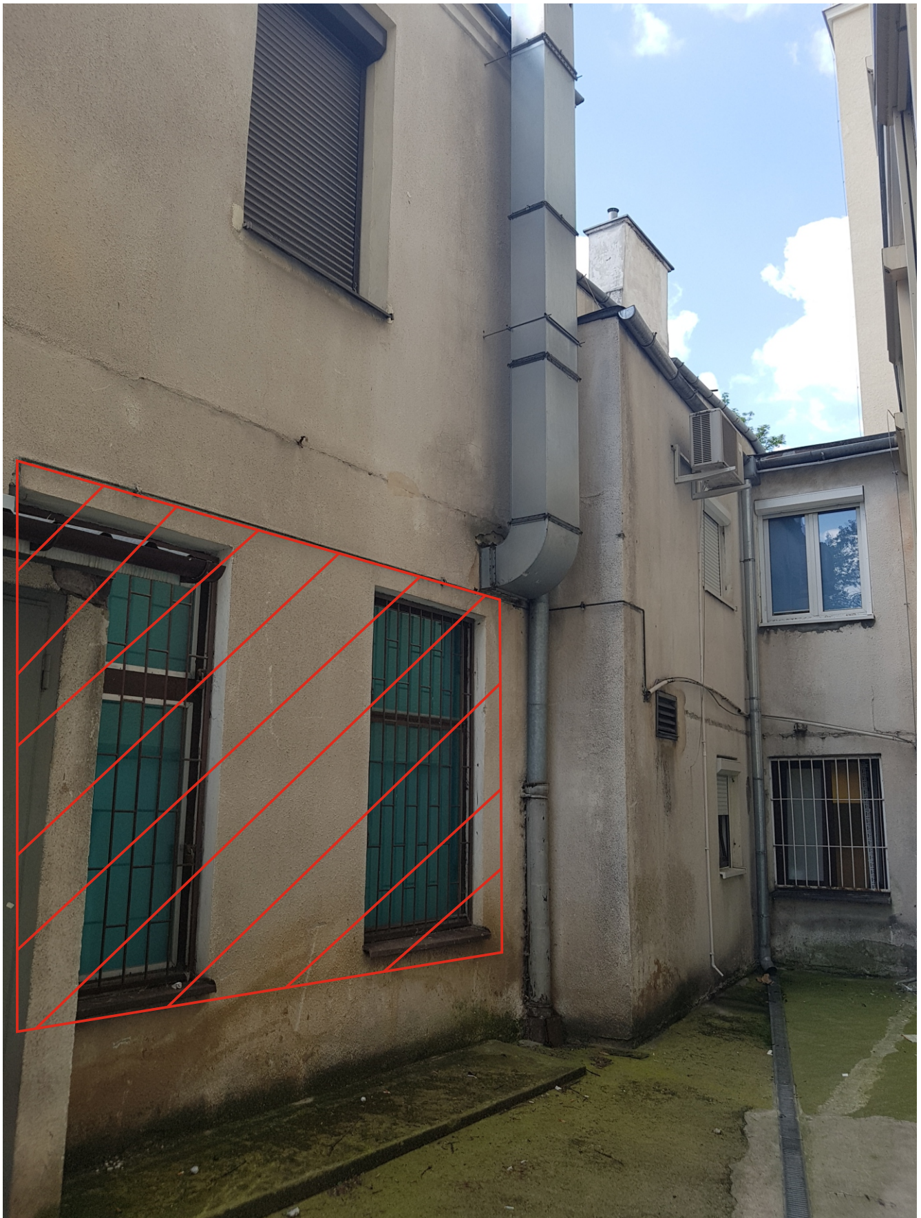
Okna do zabezpieczenia w elewacji Szpitala Okulistycznego
